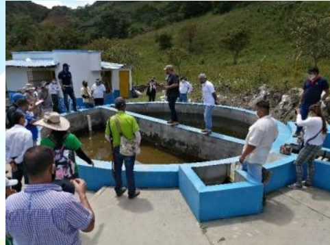
Recorrido por infraestructuras con alcaldia municipal – Filtro lento
