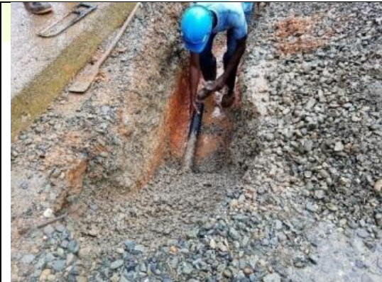
Instalación de tubería y relleno
