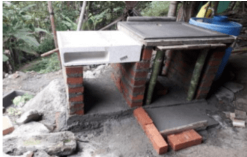
Construcción lavadero vivienda MesiasValencia
