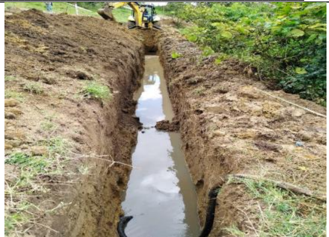
Manejo de aguas residuales tramo 7R (PTAR), tramo 5R
