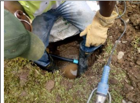
Instalación de acometidas Córdoba
