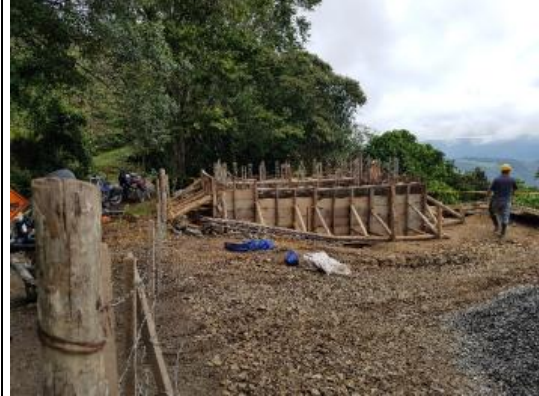
Foto Construcción Tanque de Almacenamiento Acueducto Interveredal Argelia
