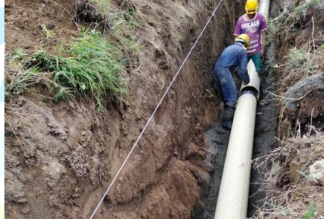
Instalación de tubería de 14 pulgadas en el tramo 7R (PTAR)
