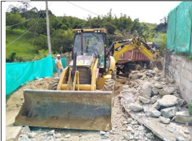
Cargue y retiro de escombros en tramos 5R, 1ALL, 5ALL
