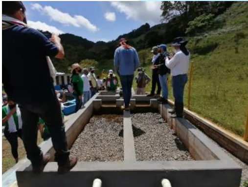
Recorrido por infraestructuras con alcaldia municipal – Filtro Grueso
