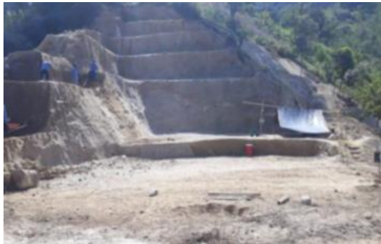
Excavación zona PTAP nivel cero.
