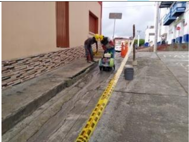
Corte con disco para la demolición del pavimento en las intersecciones y en los tramos 5R y 5ALL
