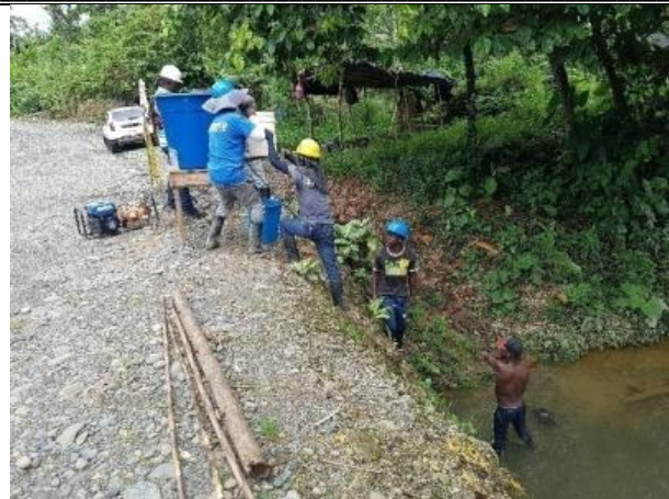
Lleno de tubería para prueba hidráulica
