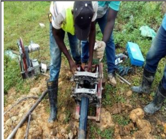
Tubo instalado en Citronela
