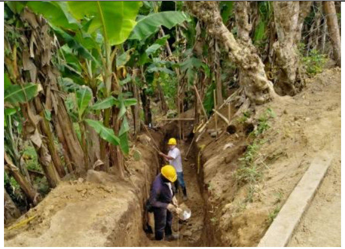
Excavación en las cámaras del tramo 7R (PTAR)
