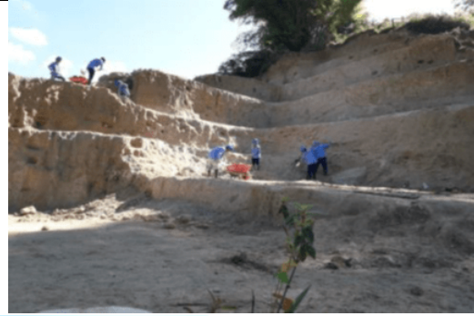
Manejo de taludes para PTAP.
