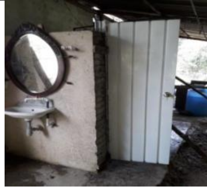
Instalación puerta Bateria Sanitaria vivienda Mesias Valencia.
