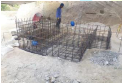
Acero de refuerzo filtro dinámico
