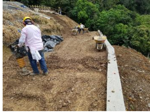
Foto Construcción Muro de Contención Acueducto Interveredal Argelia
