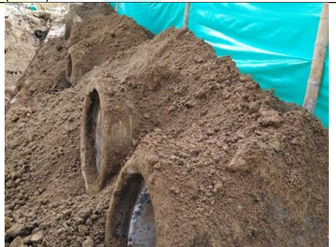
Retiro de tubería existente en los tramos 7R (PTAR)
