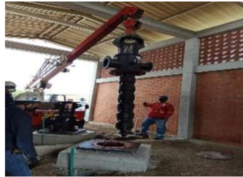
DESCRIPCION: Instalación de bombas de impulsión.
