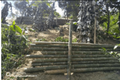
Trinchera en madera varios niveles
