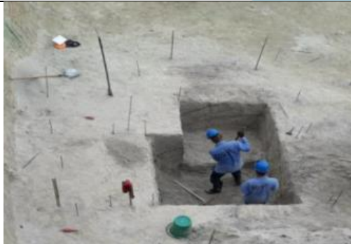
Excavación Manual Filtro Dinámico
