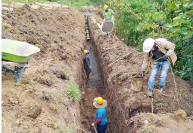
Colchon arena de 15 cm en tramo 7R (PTAR) y tramo 5R
