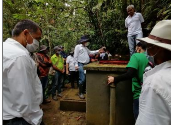
Recorrido por infraestructuras con alcaldia municipal - Desarenador
